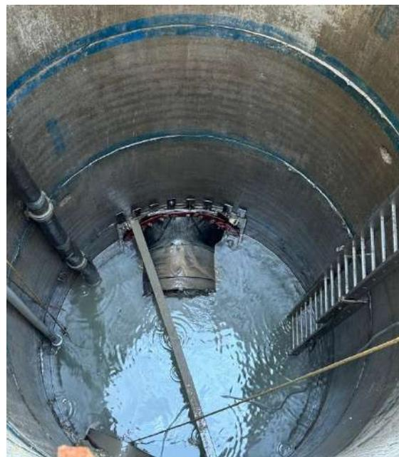
**Figura 12. a) Testa fresante ad inizio perforazione b) Testa fresante ad uscita pozzo arrivo**
